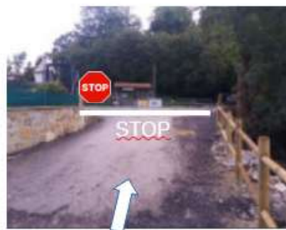
Salida a CA con señal y pintura de STOP
