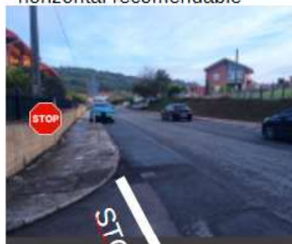
Salida a la CA, señal vertical y línea de STOP
