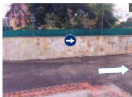
Salida del puente hacia la CA, Señal vertical obligatoria, horizontal recomendable
