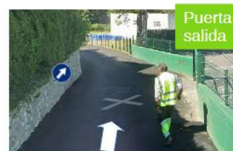
Salida de la Casa del Peque, señal vertical dirección obligatoria, hacia el puente, recomendable horizontal
