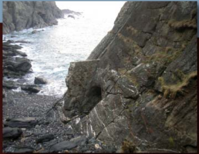
Sobre el mismo pedregal de La Turbia se aprecia la bocamina, en la que actualmente hay una toma de agua para el suministro de agua de Salta caballos.
