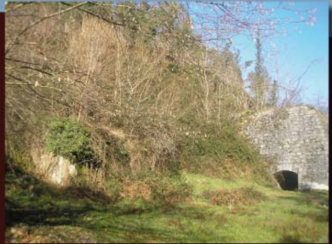
El machón de la línea de baldes se adivina a la izquierda del depósito II de Callejamala oculto entre la maleza.
