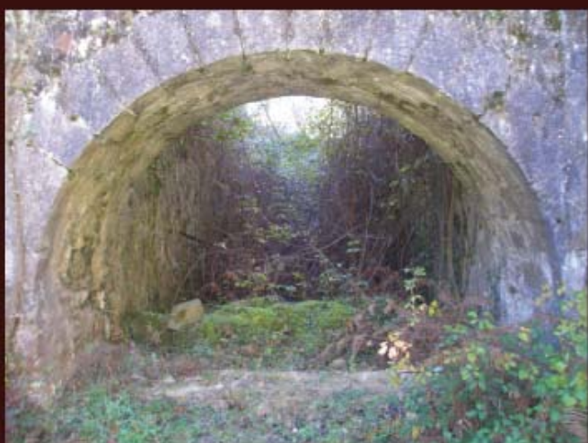
Túnel de carga de mineral.
