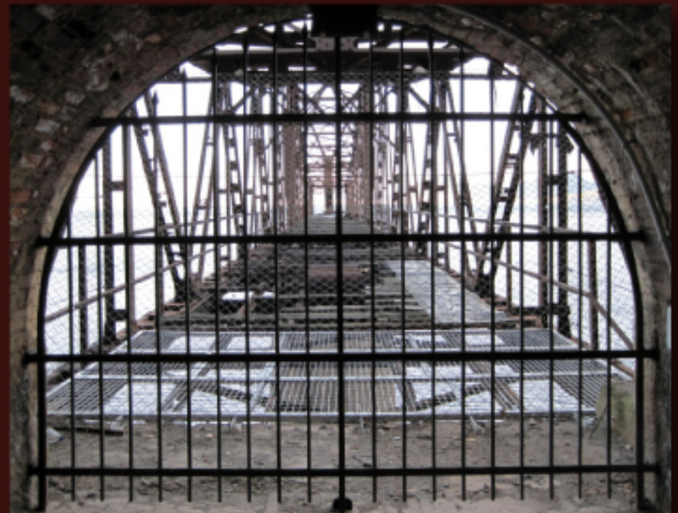
Vista del cargadero desde el túnel del depósito.
