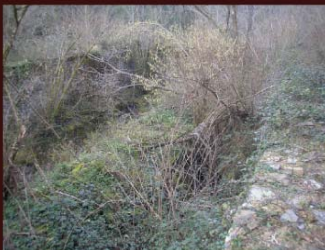
Parte interior del depósito, cubierto por la maleza.
