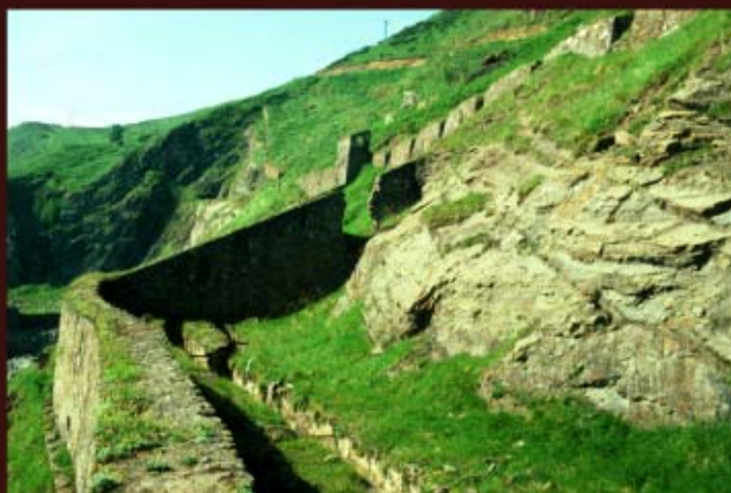
Vista interior del segundo depósito Saltacaballos.
