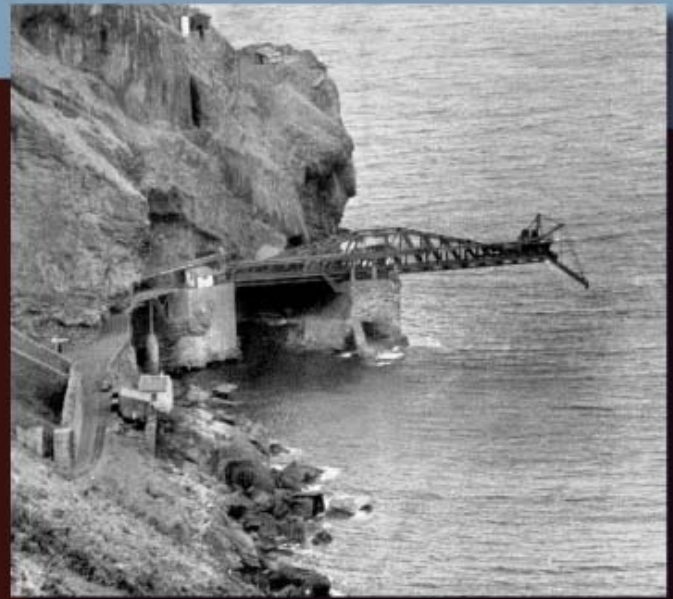
Cargadero de Saltacaballos de la Compañía Minera de Setares Construido por la casa Auguste Lecocq en 1888.
