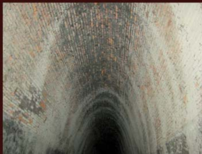
Interior del túnel.
