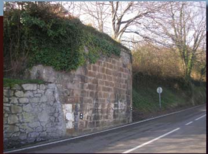
Uno de los pretiles que aún subsisten al borde de la N-634
