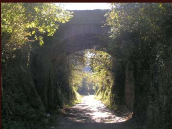
Vista de la bóveda del puente desde abajo.
