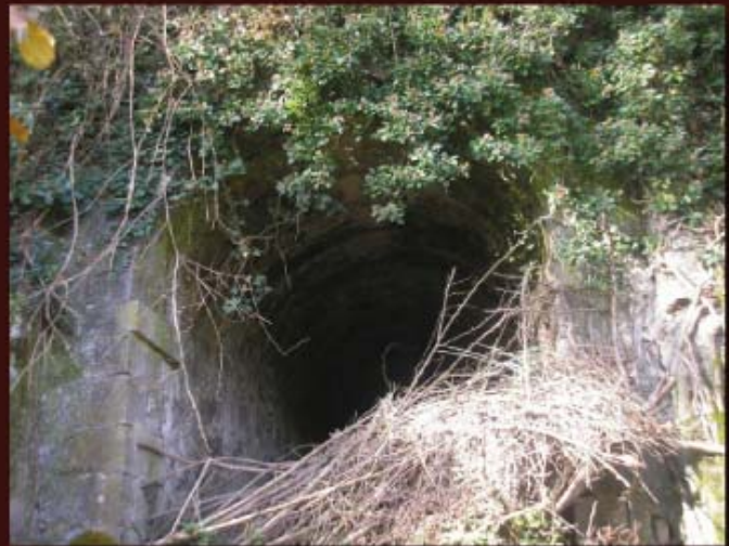
El puente en la actualidad.
