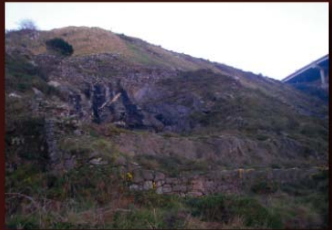
La fábrica de estos depósitos es más austera que la de los construidos por las grandes compañías mineras.
