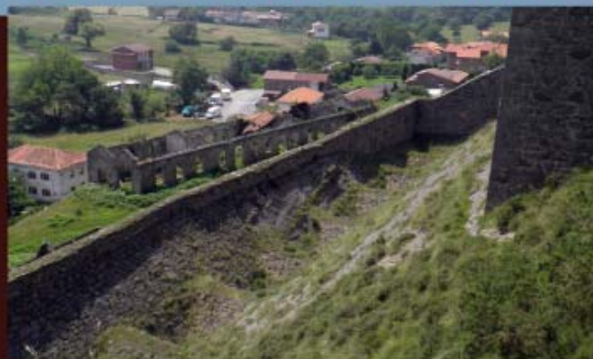
Interior del depósito del Manzanal en el que se aprecia el muro construido sobre el talúd, y en el interior las tolvas que permitían la descarga de mineral. Al fondo pueden observarse los talleres de la Compañía Minera de Setares.
