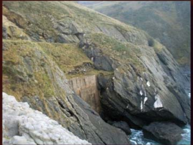
Sobre los acantilados se observa la traza de la línea de vagonetas.
