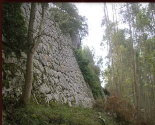
La vía de Alén sobre los muros de contención.
