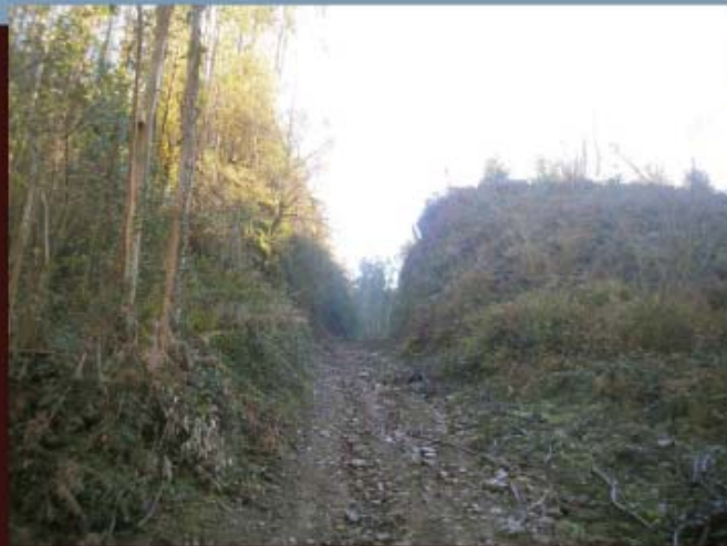
Trinchera formada por el plano inclinado de Saltolobo.
