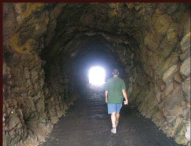
Vistas del túnel en el año 2006.
