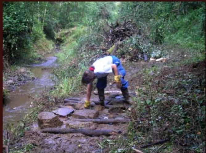
Labores de rehabilitación del poblado minero
