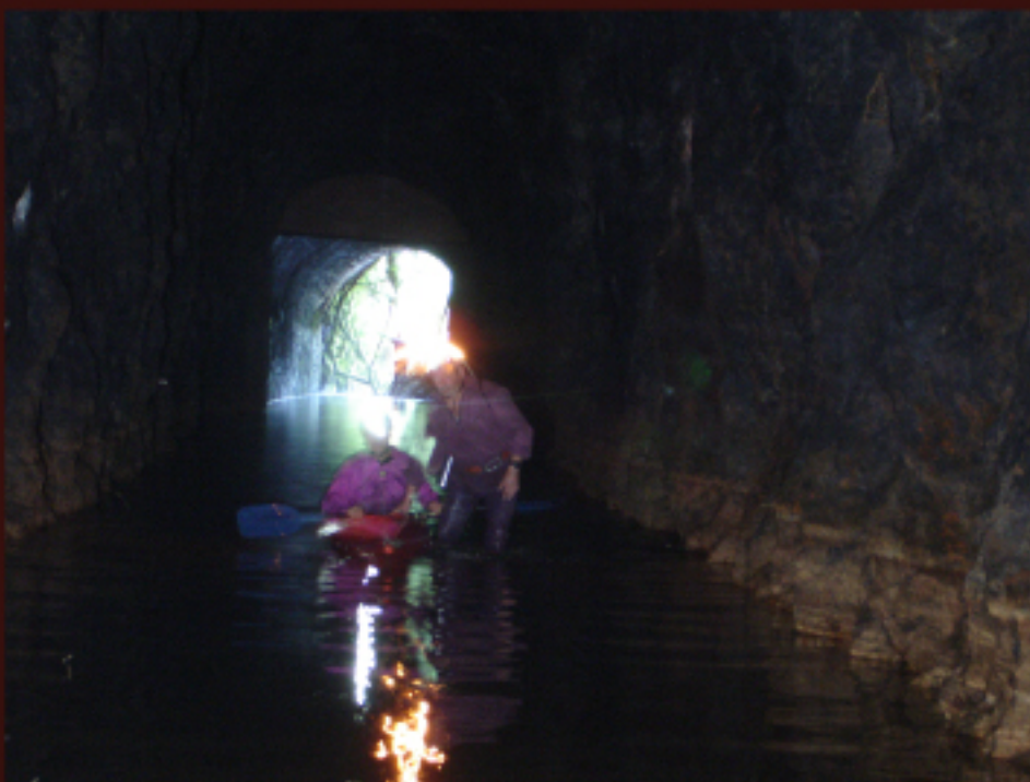
En la actualidad parte del túnel se halla anegado de agua
