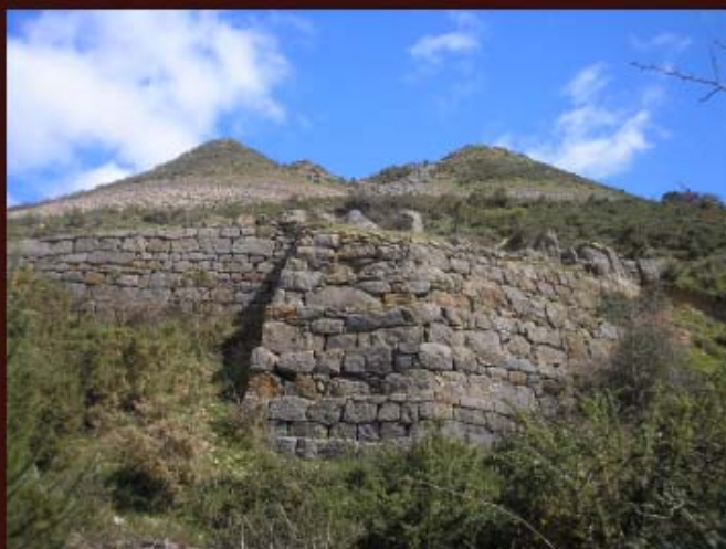
Sobre los muros de contención de un plano inclinado en la ladera oeste del monte de Dícido, se observan dos acumulaciones de residuos de mineral. Como puede verse, algunas escombreras se consolidan por la propia revegetación anatural de las mismas.
