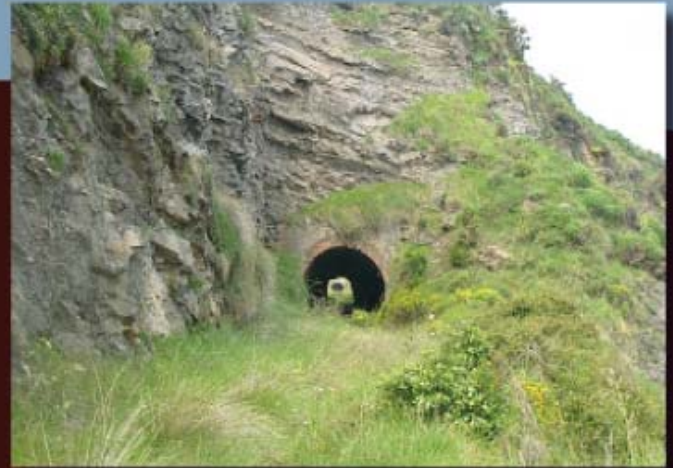
Entrada a uno de los túneles.
