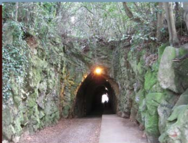
Boca Norte del túnel.
