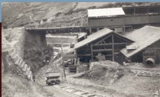
Infraestructuras de acceso del plano inclinado en las proximidades del lavadero de mineral de la compañía de Setares.
