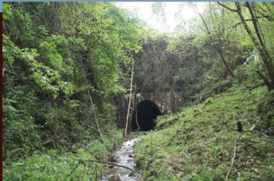
El túnel de Herreros al final de la Vía de Traslaviña
