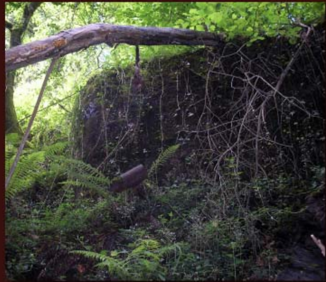
Muro de contención de canalización y depósito de agua cerca de la boca del Túnel de Herreros.
