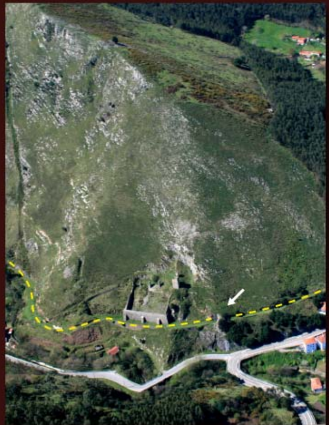
Vista aérea del tramo de la vía minera de Setaresb en la que se localiza el túnel y los muros de contención, cerca de los depósitos de mineral en Cercazosa. la flecha blanca señalala localización del pequeño túnel.
