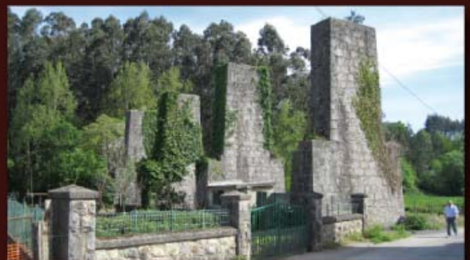
Pilares del viaducto de Dombergón en la actualidad.
