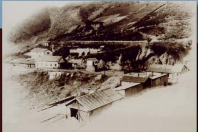
Vista general de las instalaciones de la cota 230 en las primeras décadas del siglo XX. El edificio de la izquierda con la figura al lado de la Casa Bernabea y por debajo del depósito de agua. En el centro se percibe claramente el tambor del plano inclinado, y en la parte inferior de la foto están los edificios para reparación y construcción de vagonetes y taller de carpintería.
