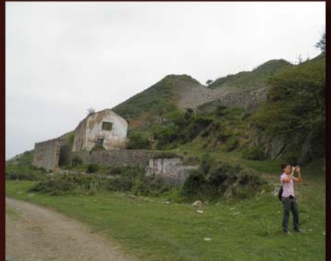
Edificios en ruinas de antiguos depósitos en la cota 230.
