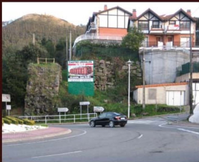
Rotonda de Brazomar con los restos del viaducto a la izquierda. Es el acceso a la vía verde de Traslaviña por un camino que se ubica detrás de un cartel publicitario.
