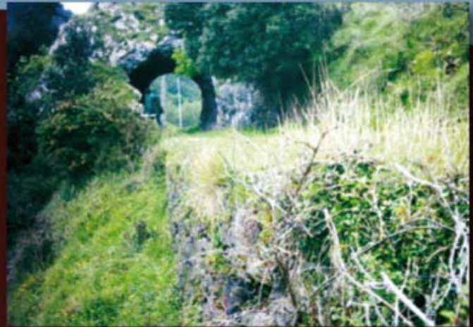
El túnel, y en primer plano, los muros de contención de la ruta entre Baltezana y Ontón.
