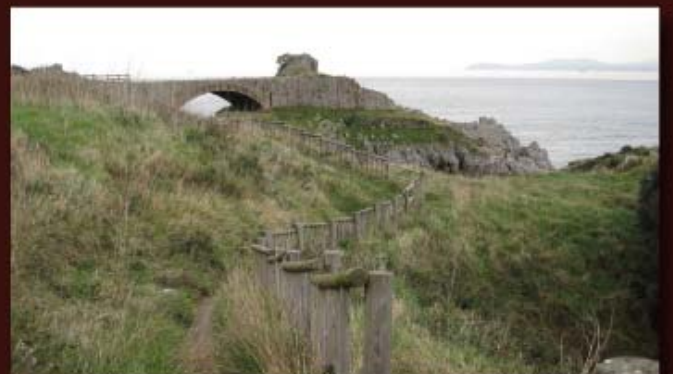
Puente y plataforma que conducían hacia el desaparecido cargadero de Urdiales.
