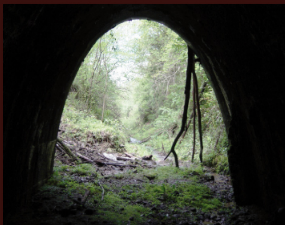
Boca norte, desde el interior.
