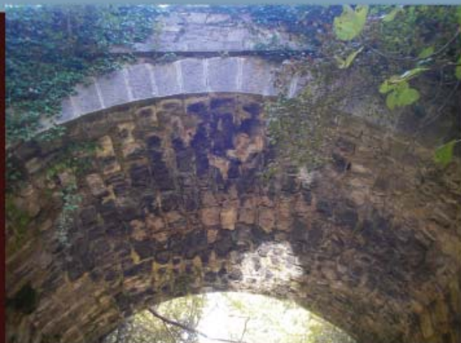
El puente sobre la vía de Traslaviña.
