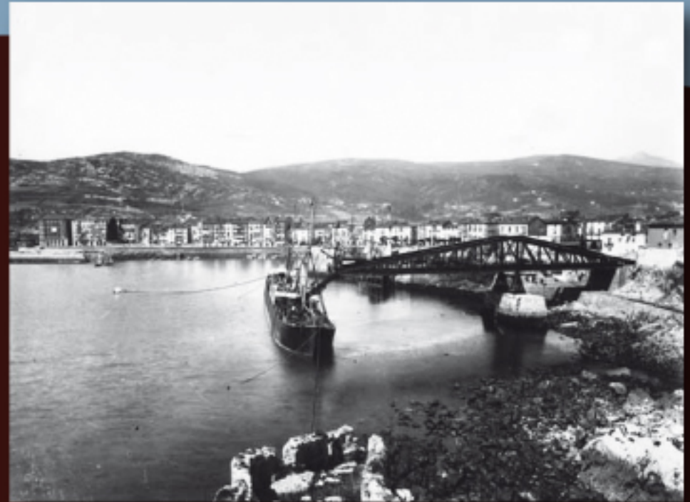
El puerto de Castro con el cargadero de Alén al fondo. Principios siglo XX.
