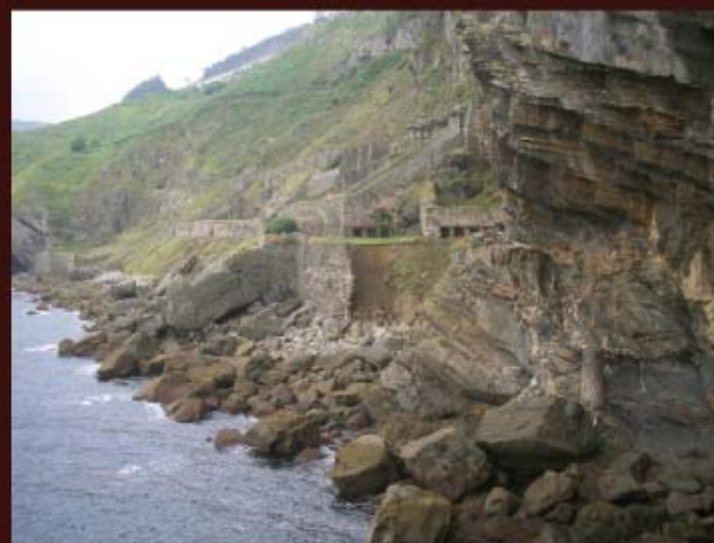
Vista desde el Oeste de los depósitos de mineral.
