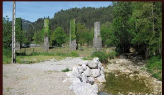
Vista de los restos del viaducto donde aun persisten sus pilares en sillería.
