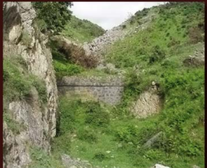
Muros de contención del segundo de los depósitos de mineral de La Turbia.
