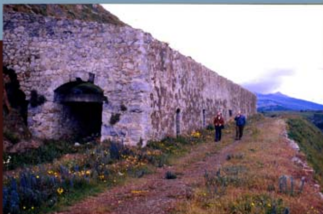
Uno de los dos depósitos de mineral ubicados en la punta de Saltacaballos. A la izquierda se aprecia el túnel de las tolveras para su posterior embarque para el cargadero de Saltacaballos. La fotos es de 1991; su estado actual es prácticamente simila pues su sólida construcción a resistido muy bien el paso del tiempo.
