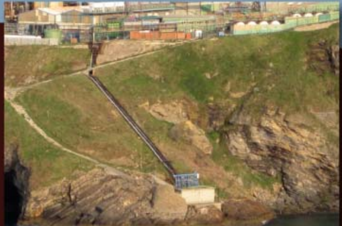
Los restos de la antiguo cargadero se encuentran a la izquierda de las instalaciones de bombeo de Derivados del Flúor, S.A.
