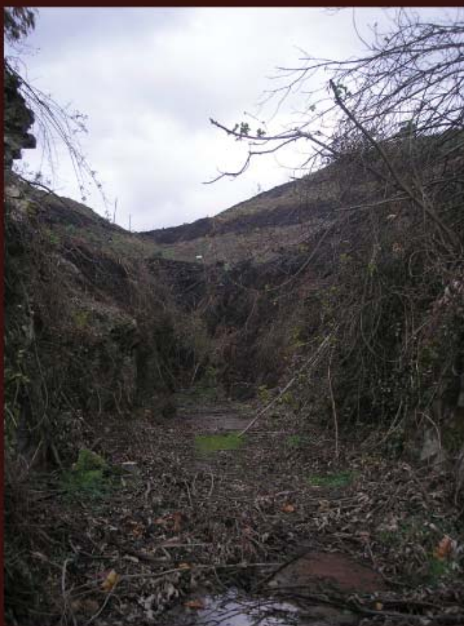
Vista general de la trinchera a la que se accede desde la vía del Piquillo.
