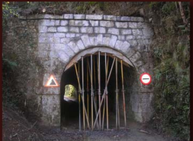
Boca norte del Túnel de Matanzas una vez reparada su embocadura en el año 2009.
