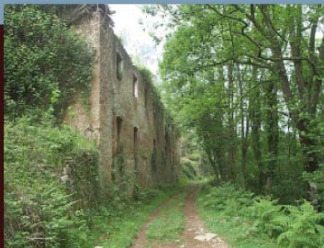
Edificio de talleres al pie de la ruta de La Gracera.
