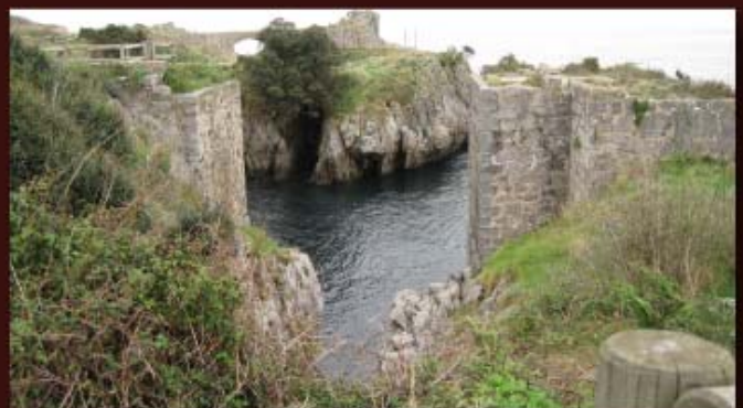
El cargadero interior frente a la infraestructura del cargadero exterior.
