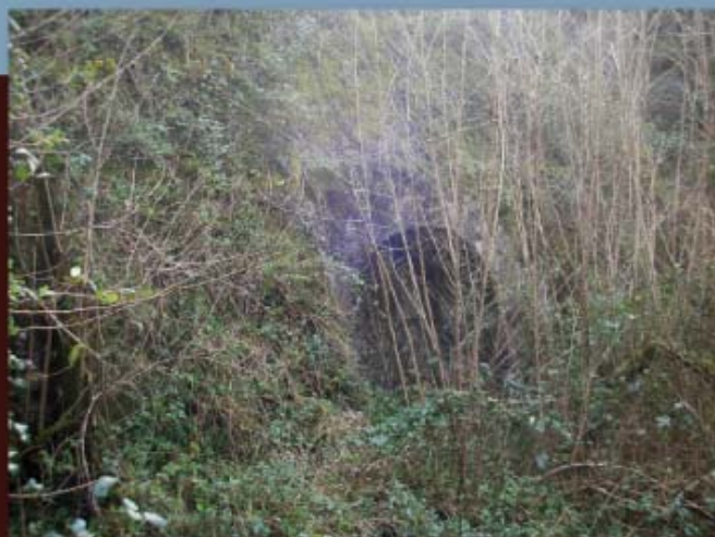
Una de las bocas del depósito.
