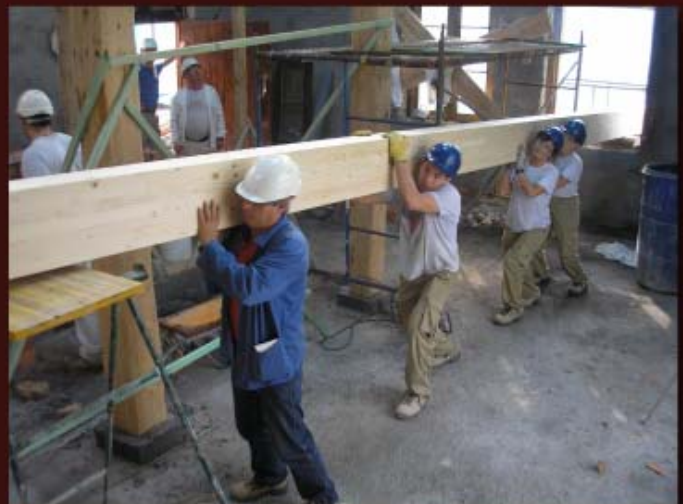
Colocación de nuevas vigas en el interior de la estación. Taller de carpintería Escuela Taller de Castro.
