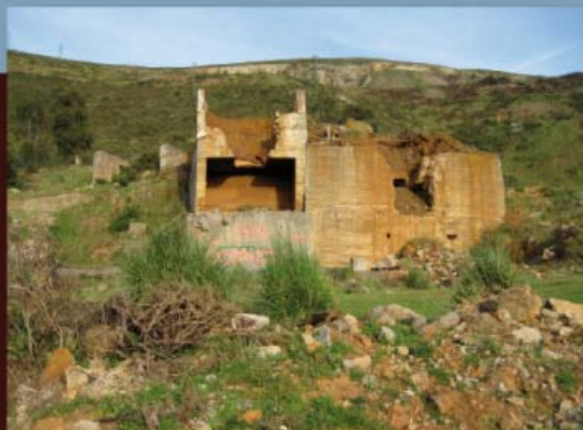
Estado actual de los lavaderos de la Cota 100.
