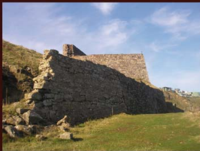
Zona de acceso a la plataforma del cargadero desde donde apreciamos las paredes del depósito de mineral.
