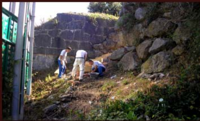
Obras de construcción de escalinata de acceso a la vía verde de Traslaviña, bordeando los restos del pretil del puente de Brazomar. Escuela Taller, año 2008
