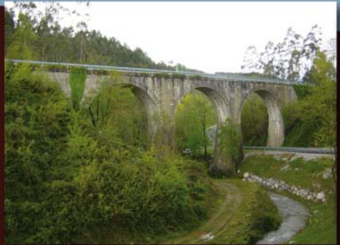
Viaducto de los Vados.
