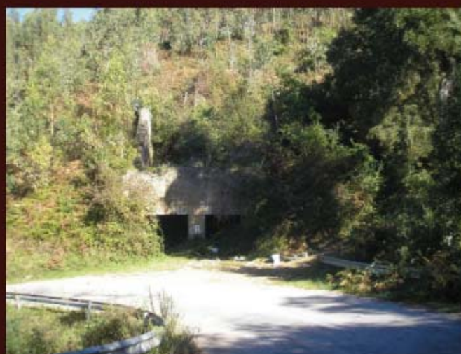
Depósitos de La Carmelita II desde la carretera Otañes - Baltezana.
