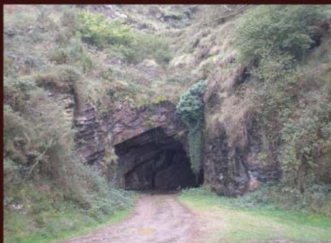
Boca Sur del túnel.
