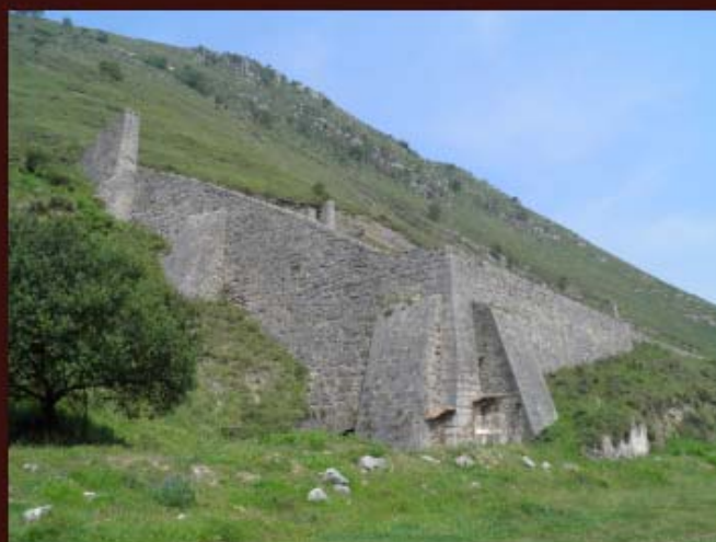
Vista general del depósito desde la vía minera de Setares a su paso por el barrio del Manzanal, en Baltezana.
