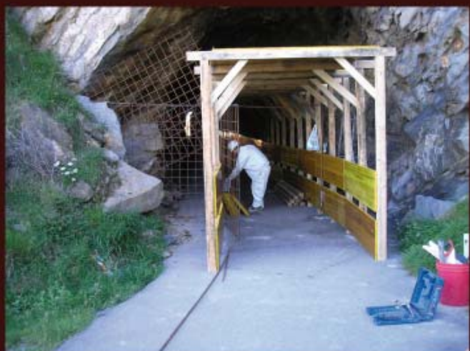
Construcción de falso túnel por el Talle de Empleo Rutas Verdes II en año 2009, para salvaguardar a los viandantes de los pequeños desprendimientos de cayuela.
