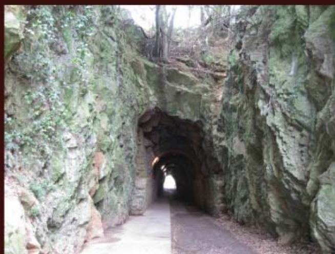
Boca Sur del túnel del Vizconde.
