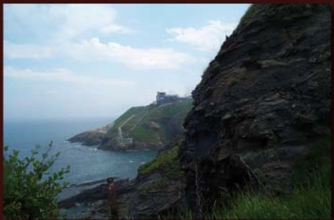
Vista de la plataforma del cargadero cuya estructura se haya afectada por una depuradora de Derivados del Flúor.
