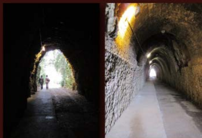
Salida del túnel en dirección a la playa de Ostende e interior del túnel.
