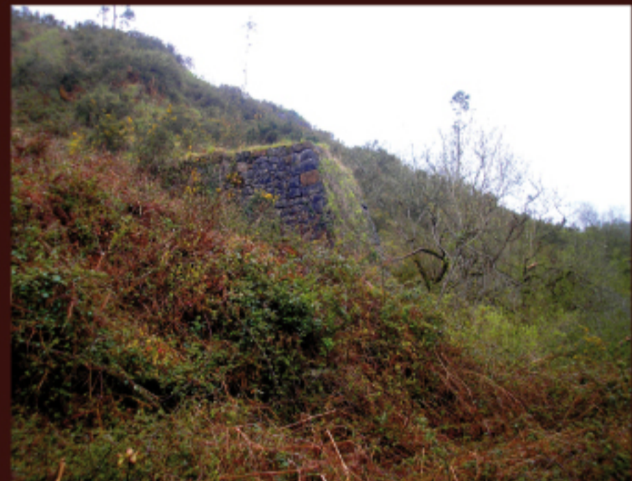
En el centro de la imagen cabeza de plano inclinado construido en sillarejo que se encuentra en el interior de la corta de La Ceferina.
