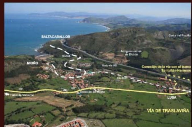
Tramo de la vía a su paso por Mioño y Lusa.
