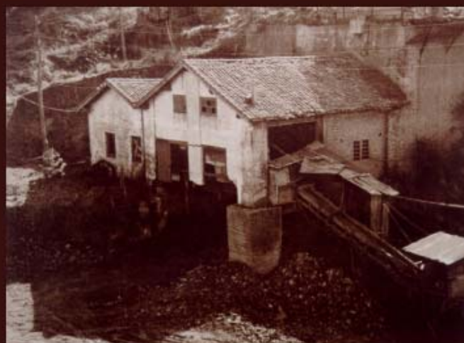
Instalaciones de la cota 100 a principios del siglo XX durante el funcionamiento de las Minas de Dícido.
