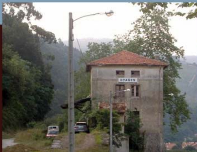
Antigua estación de Otañes. Fachada norte. Año 2007
