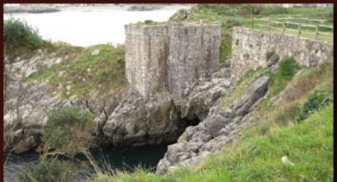
Infraestructura del cargadero interior tal y cómo se conserva actualmente.
