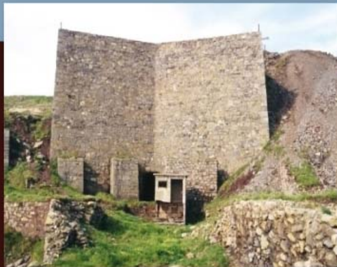
El depósito del Piquillo visto desde la plataforma del cargadero, es el más grande y reciente de los contruídos en el Piquillo.
