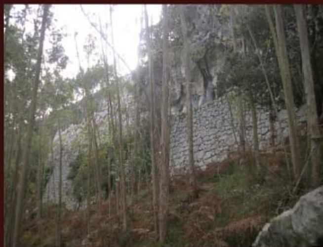
Vista de los muros desde la ladera inferior.
