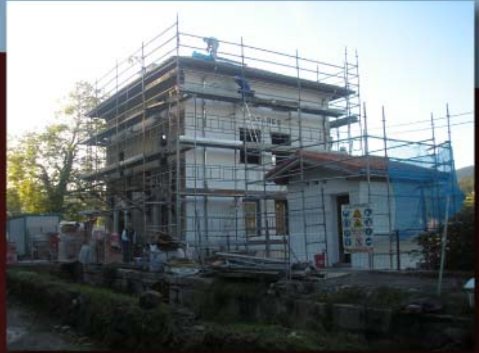
La estación durante su rehabilitación.
