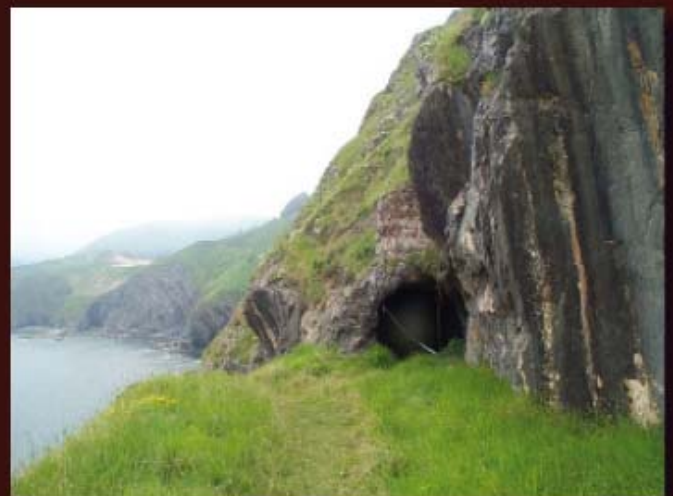
Último de los túneles llegando al depósito de la Tejilla
