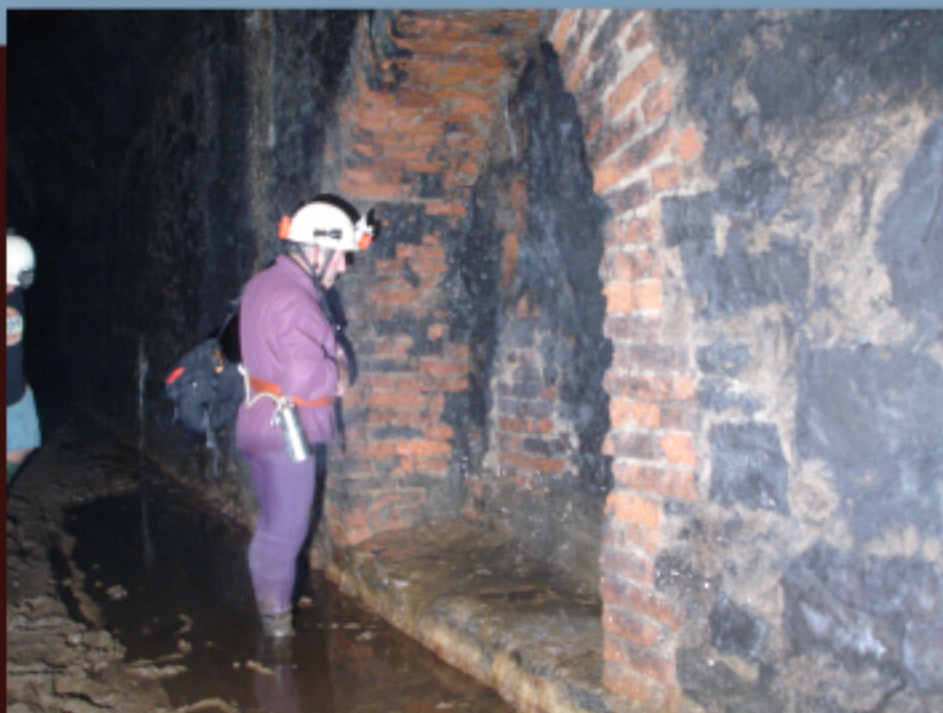
El túnel de Herreros al final de la Vía de Traslaviña
