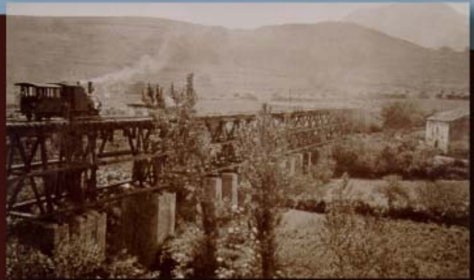
El viaducto a finales del s. XIX con la desaparecida estructura de madera.
