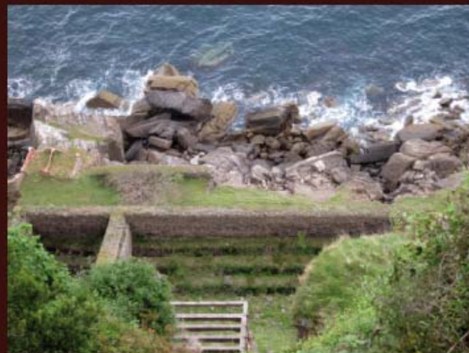
Antiguas instalaciones mineras de la Tejilla.
