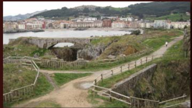
Vista de la estructura desde el Oeste.
