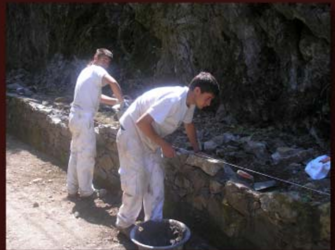
Restauración del andén del apeadero de Brazomar por el taller de albañilería de la Escuela Taller de Castro. Julio de 2008
