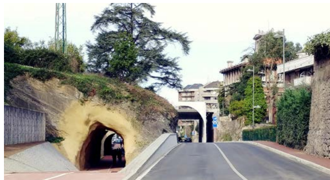
Túneles en la calle Leonardo Rucabado recientemente rehabilitados. A la izquierda el túnel de la vía verde del antiguo ferrocarril de Castro - Alén, y a la derecha el túnel de la vía verde del antiguo ferrocarril de Castro - Traslaviña.
