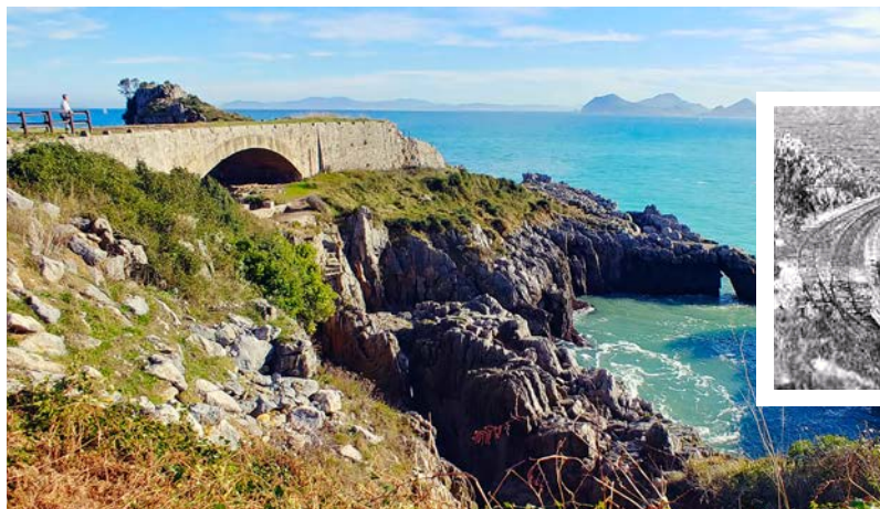
Puente del antiguo cargadero exterior de Urdiales, del ferrocarril de Castro - Traslaviña, en la punta Pepina de la ensenada de Urdiales. Forma un arco de unos 30 m. de luz. Construido en 1898, estuvo en uso hasta 1966.
