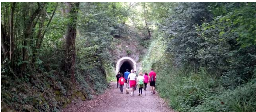
Boca norte del túnel de Valverde. El túnel mide 380 m. y comunica el barrio Brazomar con el pueblo de Mioño, una vez atravesada la falda de monte Cueto dejando atrás el bosquecillo de Valverde. Sus embocaduras son de sillería y mampostería caliza, la bóveda originaria era de ladrillo, actualmente revestida de gunitado de mortero tras su rehabilitación en el año 2011.
