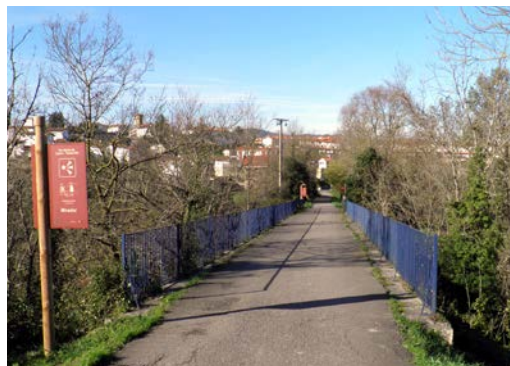
Puente de san Juan sobre el río Cabrera cerca de Santullán. 47 m. de longitud, y 17 m. de altura, construido en sillería caliza, con tipología de arco de medio punto.
