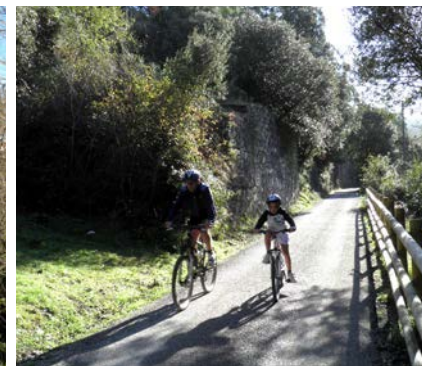
La vía verde entre la estación de Otañes y el viaducto de Los Vados en una zona en la que se observa el muro del depósito de mineral de la Carmelita.
