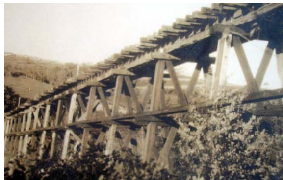
Pilastras de Dombergón en el valle de Sámamo. 10 pilares de sección trapezoidal construidos en silería y sillarejo caliza de planta cuadrada de 7 m. de lado y estructura trapezoidal, alcanzan 11,25 m. de altura. Sobre ellos se sostenían las vías del ferrocarril minero de Castro Alén que vadeaba en este punto la carretera de Hoz y el río de Sámamo. Fueron construidas hacia 1890.
