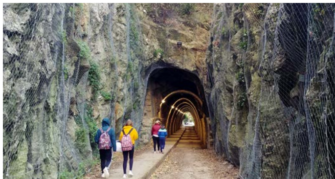
Túnel del Vizconde, de 170 m., excavado en roca caliza con embocaduras de mampostería y parcialmente abovedado con ladrillo macizo. Comunica las calles Leonardo Rucabado con la avenida Menéndez Pelayo y la playa de Ostende.
