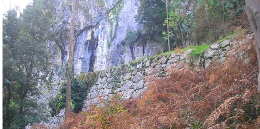
La vía verde Alén a su paso por la falda del Pico de la Cruz, entre Santullán y Otañes. El firme de la vía verde en este tramo se soporta por unos enormes muros de contención construidos en piedra caliza.
