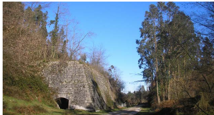
Los Puertos de Callejamala, final de la vía verde de Alén. El primero de los depósitos ocupa una superficie de unos 2.000 m 2 , dividido en dos compartimentos, construido en sillarejo de piedra caliza con tres aperturas en arco de medio punto en los muros anterior y posterior, y cuatro en el muro lateral, desde el que salían los vagones cargados de mineral. El segundo de los depósitos ocupa una superficie de unos 2.500 m 2 y un solo compartimento, construido en sillarejo de caliza. Almacenaban el mineral que provenía mediante ferrocarril aéreo desde las Minas de Alén.
