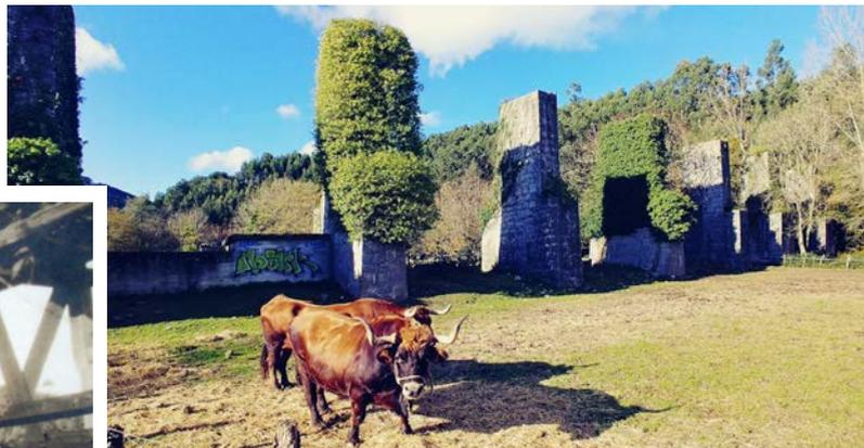
*Pilastras de Dombergón en el valle de Sámamo. 10 pilas de sección trapezoidal construidas en silería y sillarejo caliza de planta cuadrada de 7 m. de lado y estructura trapezoidal, alcanzan 11,25 m. de altura. Sobre ellos se sostenían las vías del ferrocarril minero de Castro Alén que vadeaba en este punto la carretera de Hoz y el río de Sámamo. Fueron construidas hacia 1890.*
