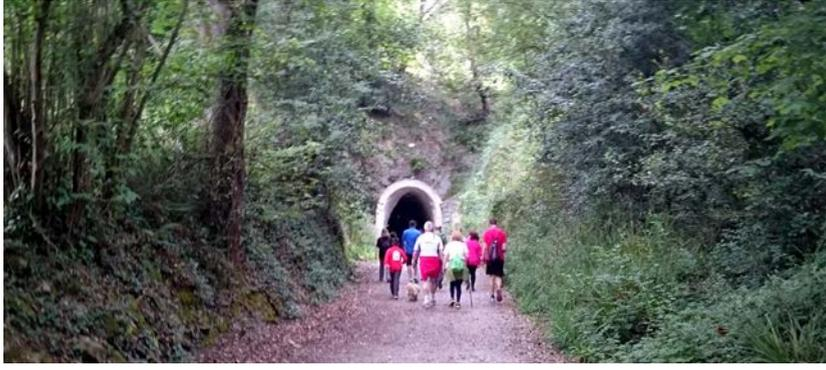
*Boca norte del túnel de Valverde. El túnel mide 380 m. y comunica el barrio Brazomar con el pueblo de Mioño, una vez atravesada la falda de monte Cueto dejando atrás el bosquillo de Valverde. Sus embocaduras son de sillería y mampostería caliza, la bóveda originaria era de ladrillo, actualmente revestida de gunitado de mortero tras su rehabilitación en el año 2011.*
