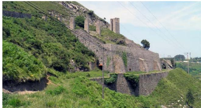
Depósito de mineral de la Cercazosa. Construido a finales del XIX en sillarejo caliza con muros de 1 m. de ancho, y de 20 x 40, cerrando el fondo también con la ladera del monte; se conservan las 7 pilastras que sostenían la línea de baldes. Se encuentra a 200 m. del depósito de mineral de El Manzanal.
