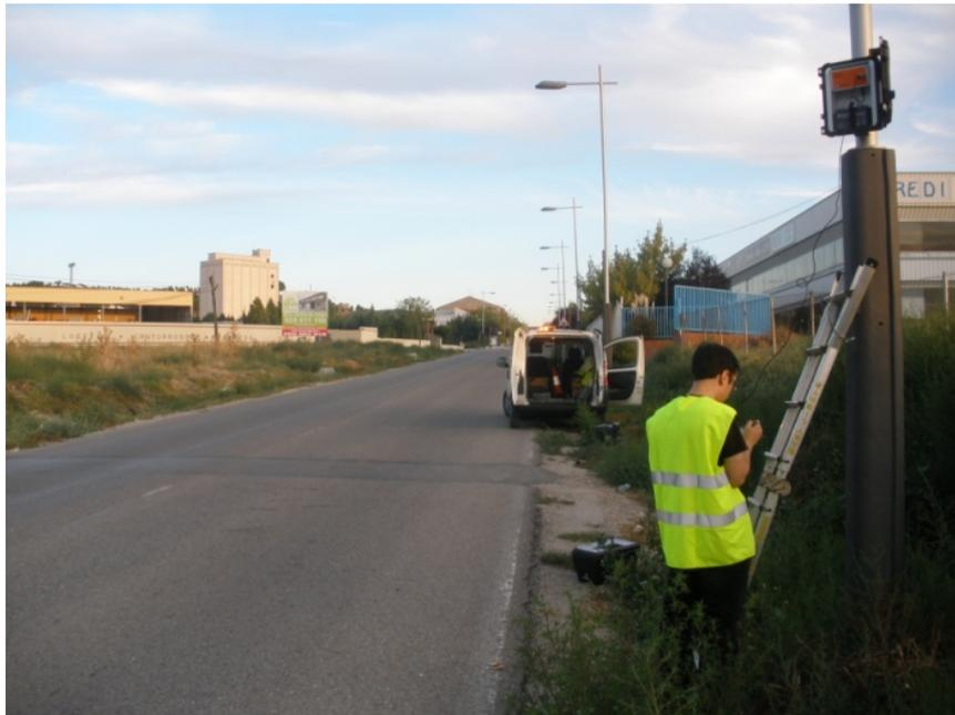
*Imagen 13. Técnico de Vectio procediendo a la calibración de aforador de tecnología radar.*
