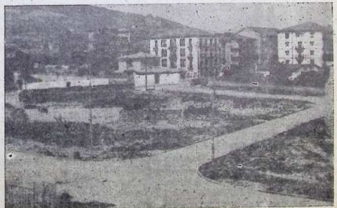
Una vista del nuevo ensanche en su estado actual.
