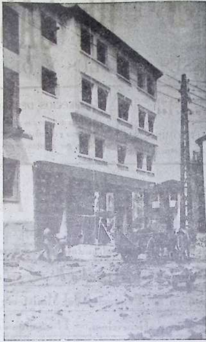
El edificio en construcción de viviendas para los maestros anejo a los nuevos edificios para dependencias oficiales y que corresponde a la edificación del nuevo ensanche
