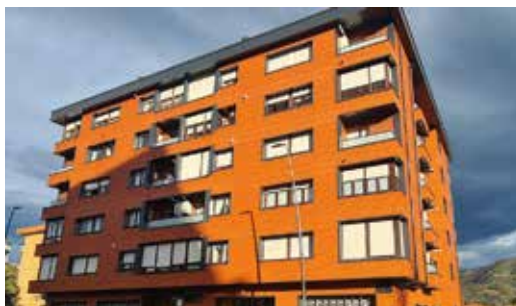
Rehabilitación de fachada ventilada
