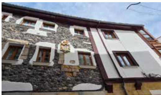
Restauración de Fachadas en Ardigales
