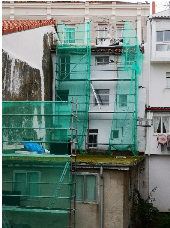
Alero en mal estado por donde las palomas acceden al bajo tejado.
